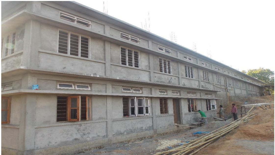
Schulhaus kurz vor dem Fertigbau
